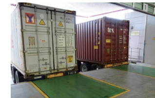
段差を調整するドックレバラー
